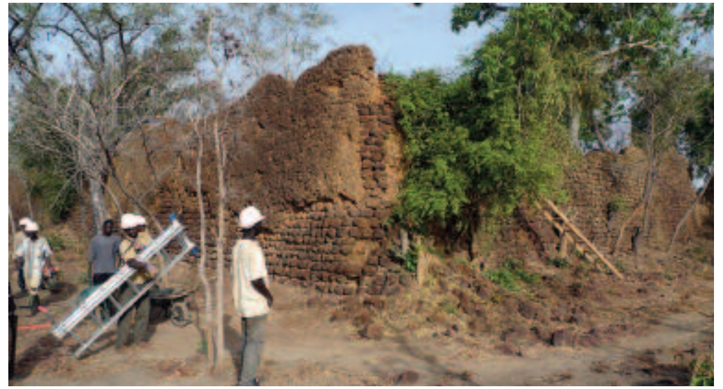
L'angle Sud-Est des ruines avant les travaux de stabilisation
