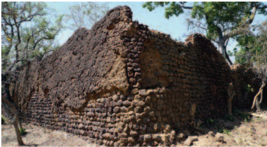
L'angle Sud-Est de Loropéni après les travaux de stabilisation
